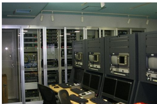
エンコード作業室
